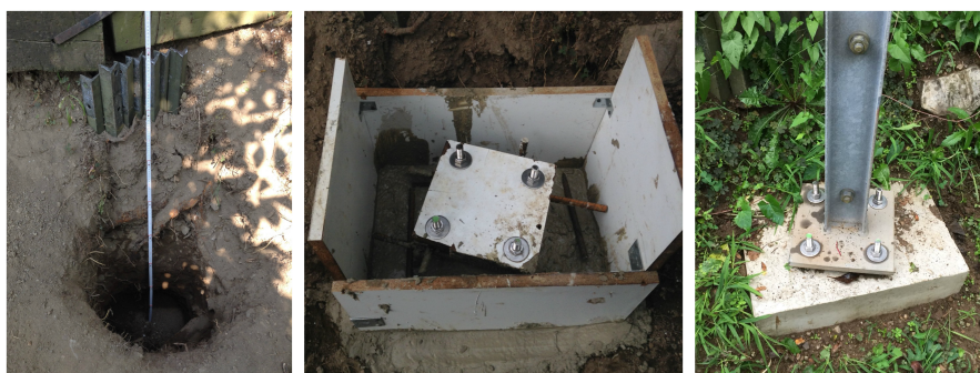
Fig. 3.4: Sequenza di foto che illustra il processo di costruzione base del pilastro.
