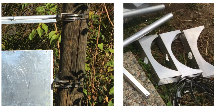
Fig. 3.7: Sostegno laterale sul palo in legno (sostegno destro).
