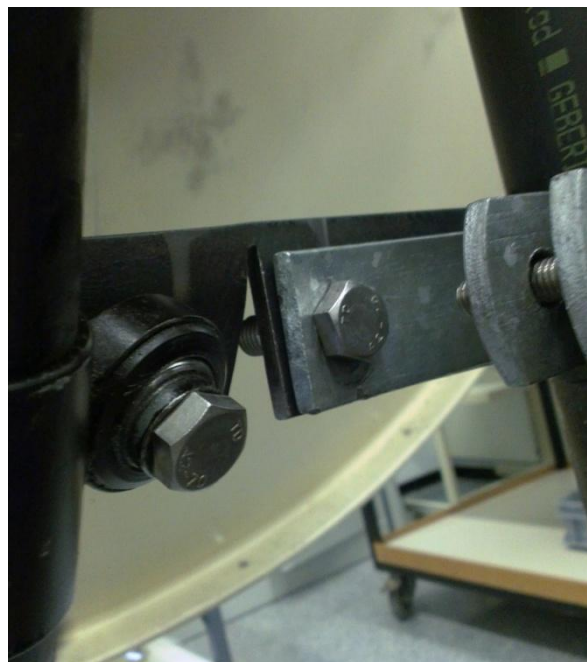
Figura 39: Nuova prospettiva della struttura descritta sopra, si può notare il taglio eseguito, affinché l'angolatura prodotta dal cuscinetto sferico posto accanto il taglio non supera la capacità di rotazione della sfera, evitando la rottura degli elementi citati.
