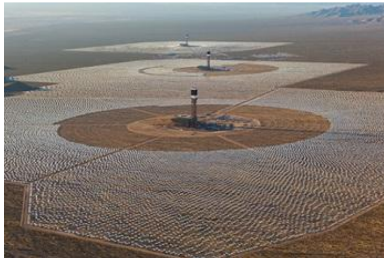
Figura 6; L'impianto Ivanpah (California) rappresenta magnificamente l'imponenza di questa tecnologia. Grazie ai suoi 14.2 km 2 e a una potenza di 377 MW netti (392 MW totali) riesce a fornire energia a 140'000 abitazioni. Fonte: [G].
