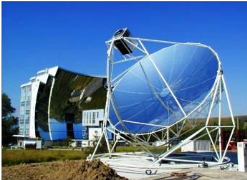
Figura 3: Il generatore EnviroDish realizzato nel 2006 presso la sede della fornace Solare di Odeillo (SPA) è un ottimo esempio di paraboloide solare. Questo impianto, utilizzando il ciclo di Stirling, con i suoi 56 m 2 di superficie raggiunge una potenza elettrica massima di 9,5 kW. Fonte: [C].
