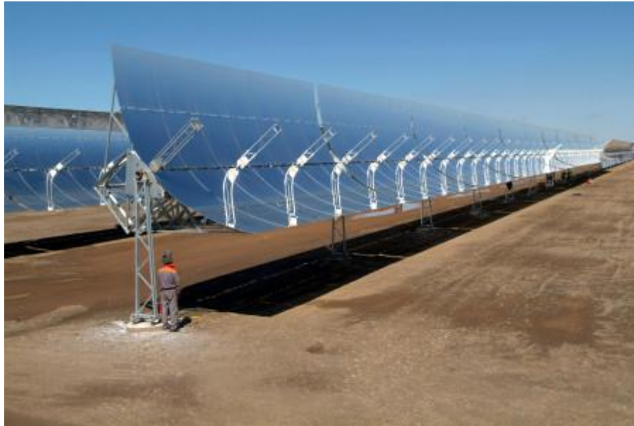
Figura 4: Collettore parabolico lineare in costruzione. Dato che questa struttura non segue l'angolo azimutale del sole, il fuoco del collettore è continuamente in movimento, ma questo moto si traduce come una traslazione sulla retta davanti allo specchio parabolico, la quale rappresenta il ricevitore del collettore parabolico. Fonte: [D].
