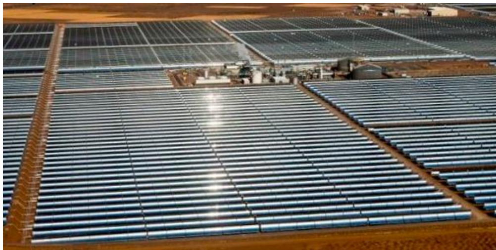
Figura 5: Il concentratore Andasol 1 in fase di costruzione realizzato a Guadix, nella provincia di Granada (SPA) è un impianto costituito da 156 schiere di collettori parabolici lineari, che raggiungono una superficie di 510'120 m 2 con una potenza di 49,9 MW (fig.4). Fonte: Ecoapplicazioni.it, www.cleanenergyactionproject.com e ener-coop.es . Fonte: [E],[F].
