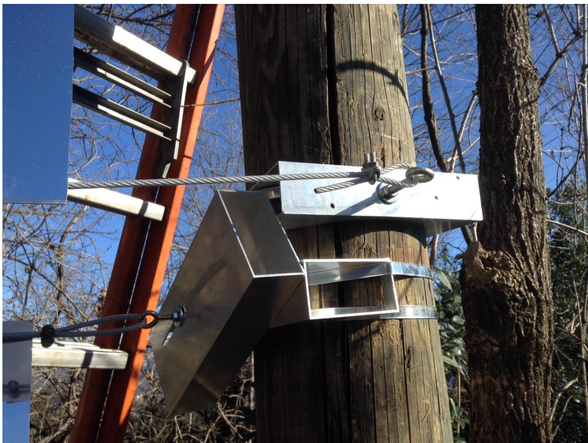
Figura 18: Archi che fissano goniometri e cavi fissi
