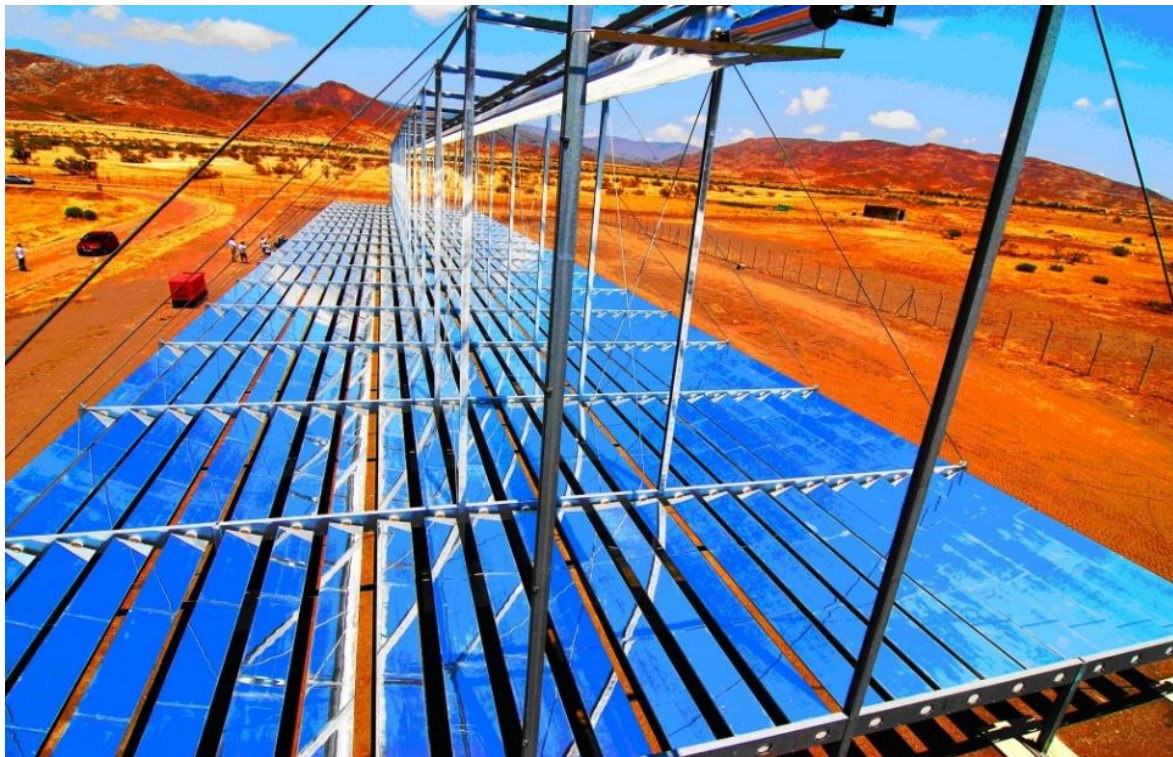
Figura 7: Concentratore lineare Fresnel
