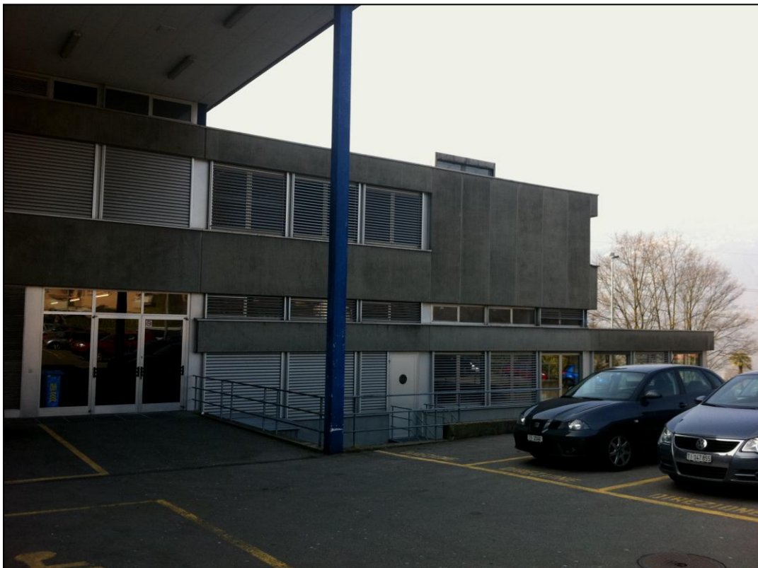
Figura 4.6: stabile del liceo - piani sovrapposti in modo energeticamente dispersivo.
