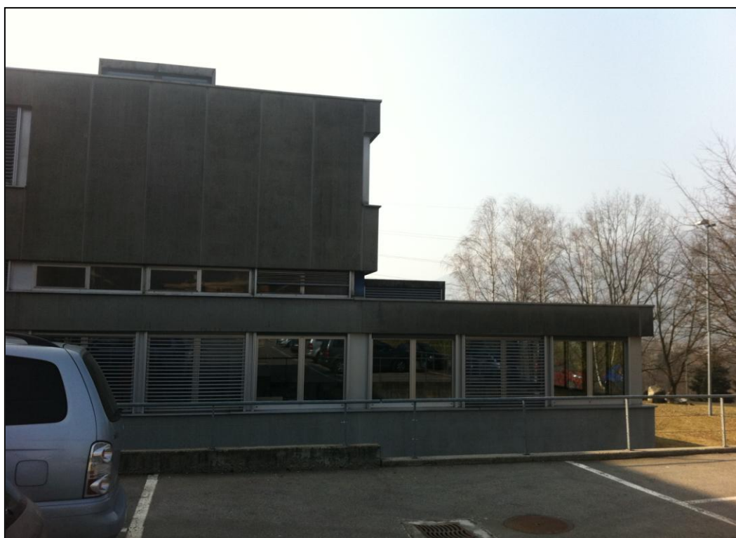
Figura 4.7: stabile del liceo - sovrapposizione di piani energeticamente dispersiva.
