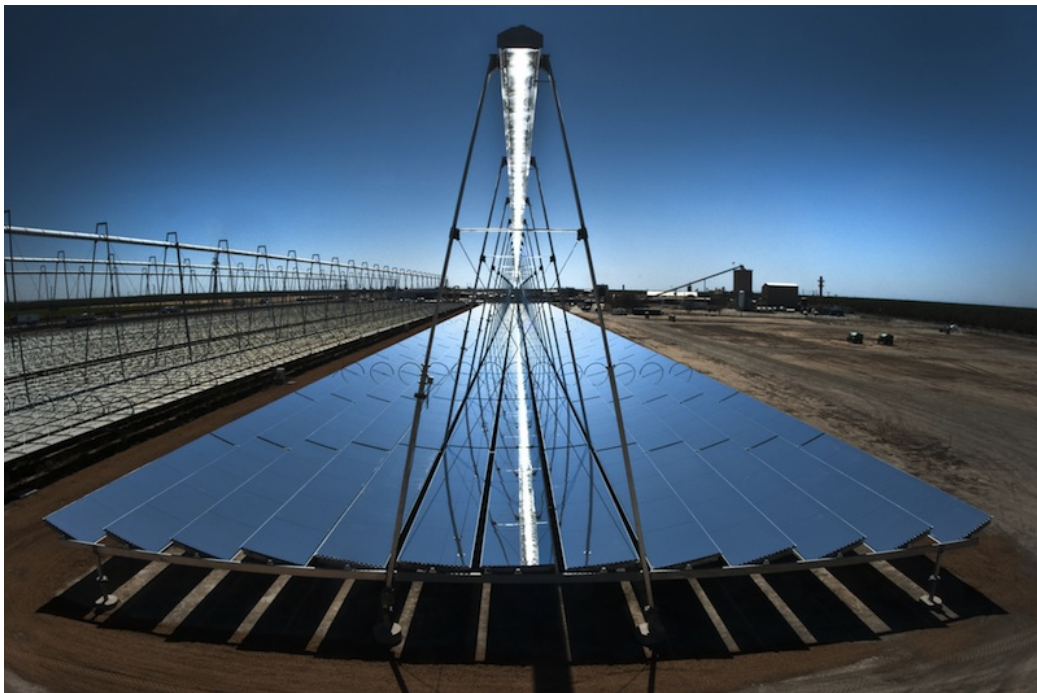
Figura 5: AREVA Solar's Compact Linear Fresnel Reflector: esempio di concentratore solare di Fresnel sviluppato dalla multinazionale francese AREVA
