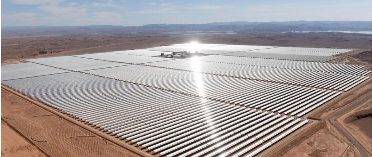
*Figura 4: Impianto Noor, a Ouarzazate, in Marocco. Si tratta di gronde paraboliche.*
