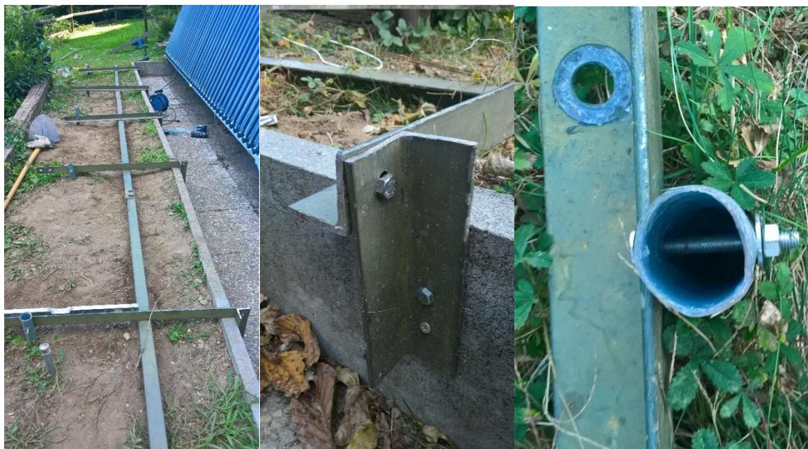
Figura 10: La "colonna vertebrale"; fissaggio delle vertebre, a destra a un muretto e a sinistra a un paletto ancorato nel terreno.
