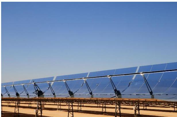
*Figura 5a: Noor II, a Ouarzazate in Marocco. Si tratta di gronde paraboliche*
