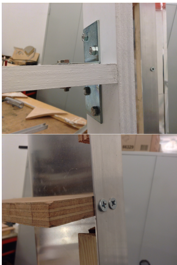
Figura 5: Questo doppio attacco permette di avere una stabilità maggiore tra la costola e l’asse, rispetto al precedente metodo, mostrato nella sezione inferiore dell’immagine.
